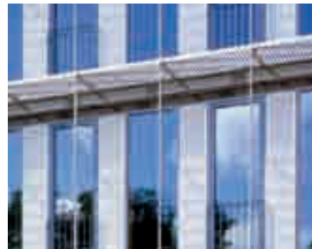
Fassadenausschnitt zur Gartenseite.
